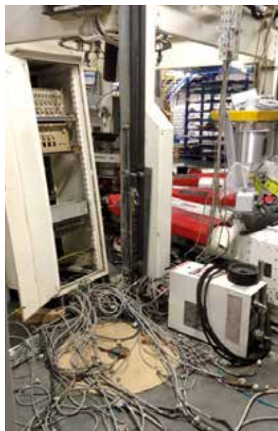
Alter Schaltschrank „entkernt“
