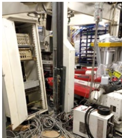
Alter Schaltschrank „entkernt“
